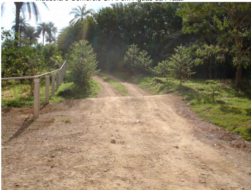
Foto 27 – Tubulação de transferência de água mineral para as instalações de produção (em estágio de pré-operação) da Fonte Platina Indústria e Comércio S. A. em Águas da Prata.
