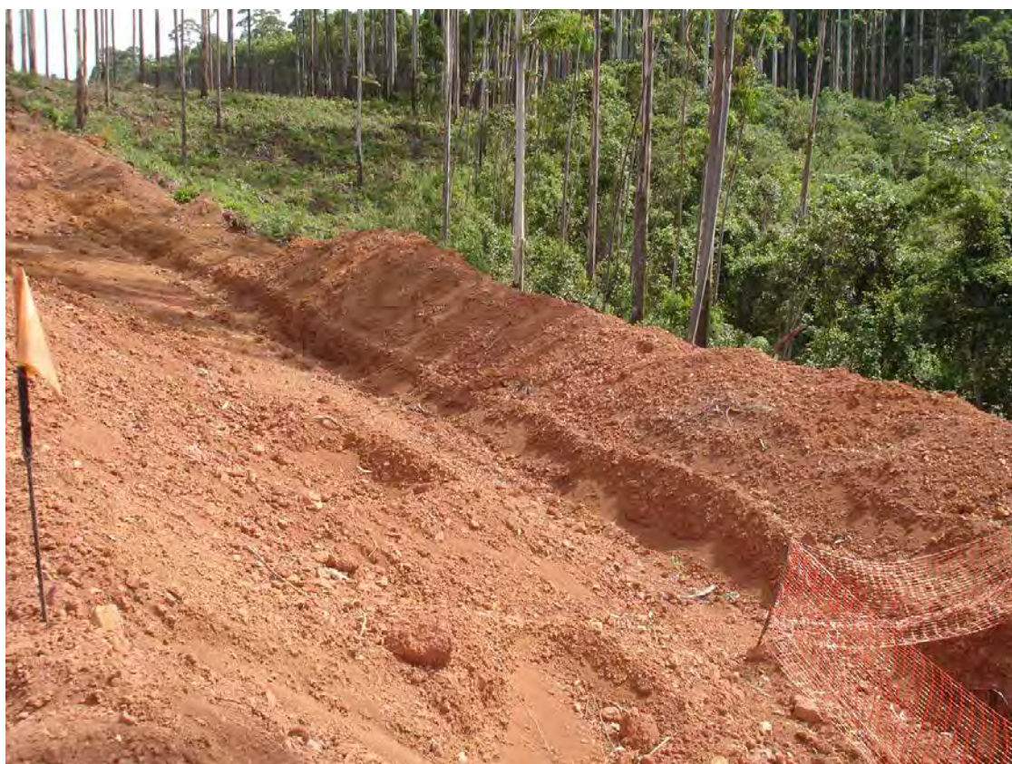
Foto 10 - Construção de canaleta do sistema de drenagem na área em lavra.
