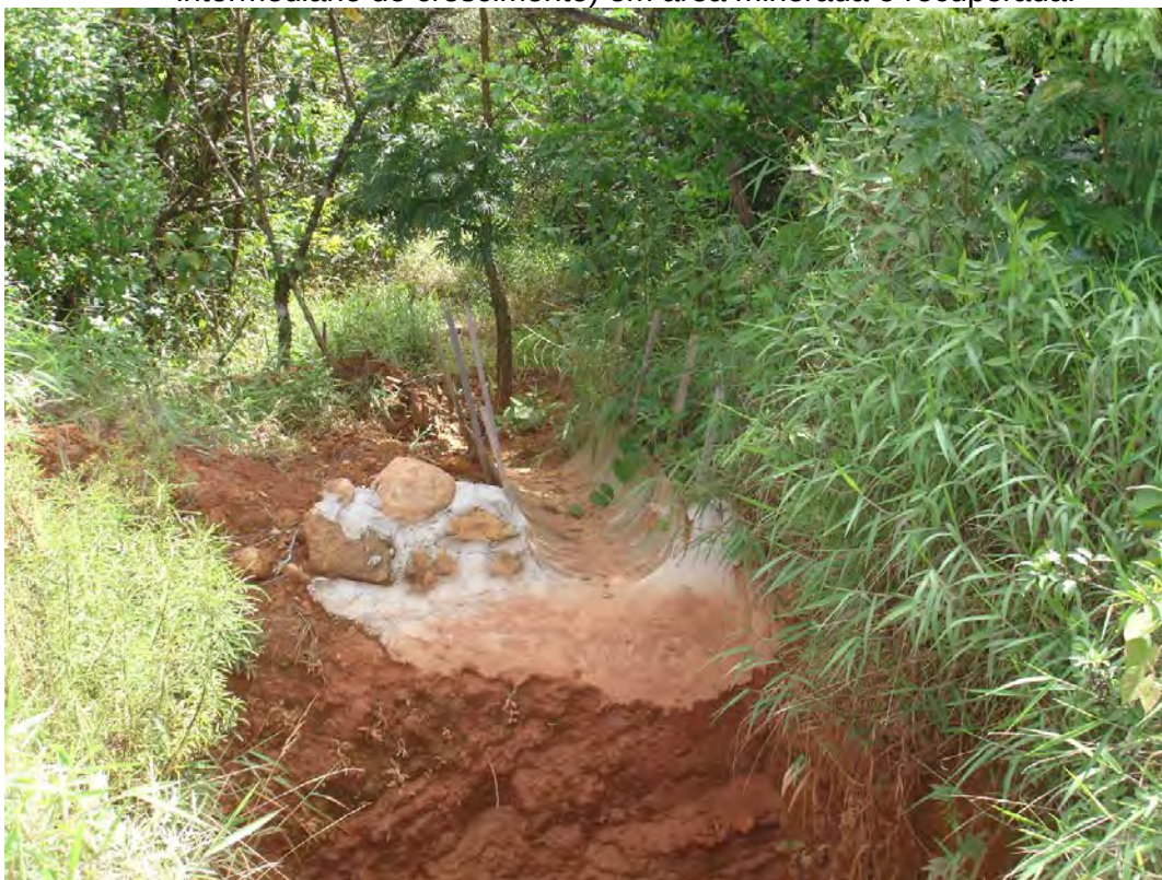
Foto 14 - Detalhe construtivo de poço de recepção de águas pluviais em ponto limítrofe de área minerada e recuperada com plantio de espécies nativas.
