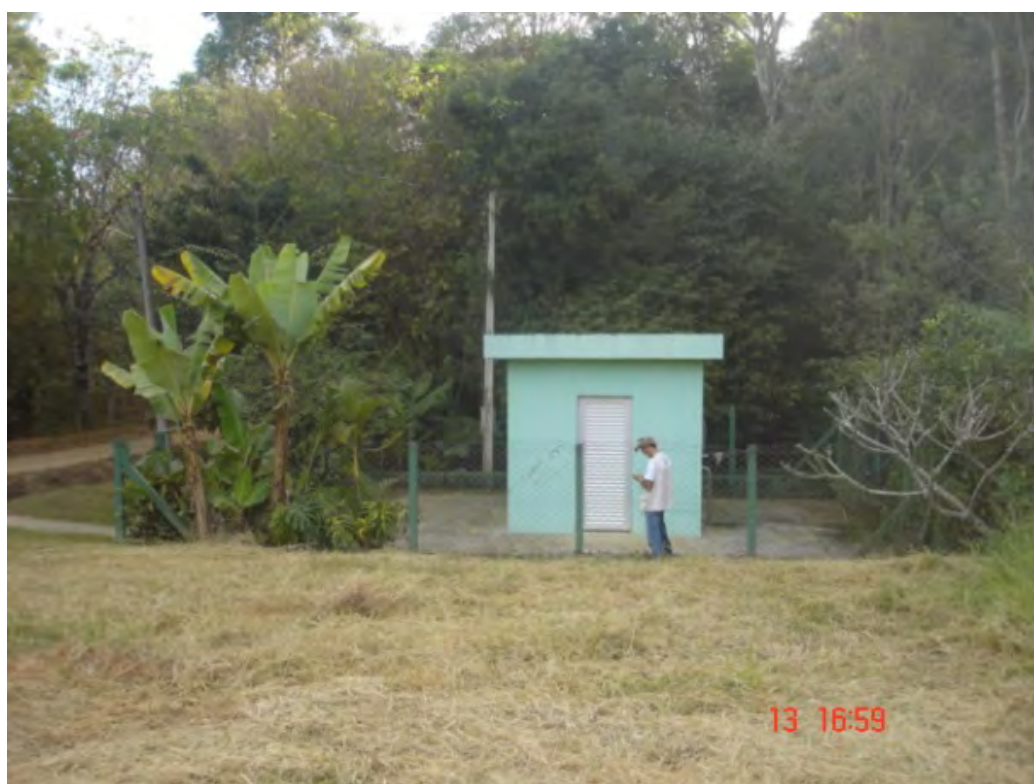
Foto 64 – Vista geral do local de captação da fonte de água mineral da Mineral MB em Espírito Santo do Pinhal.
