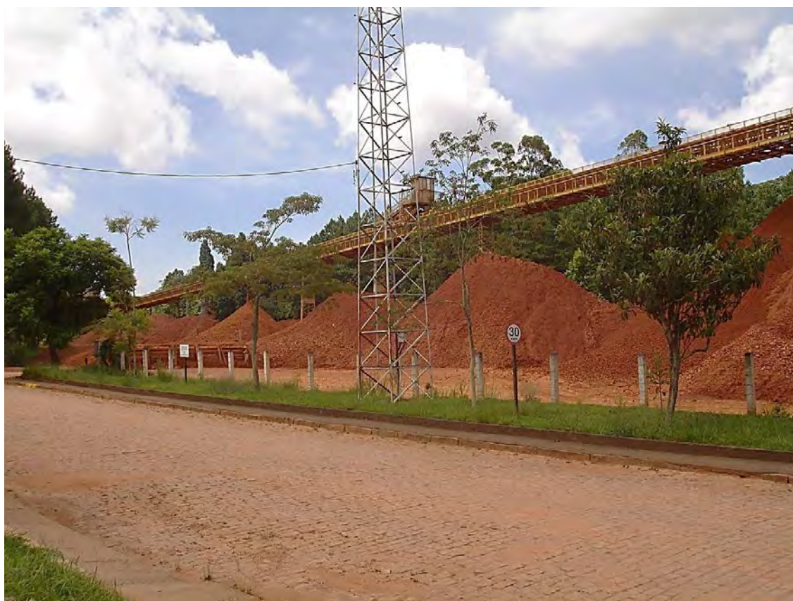
Foto 17 - Vista geral das pilhas de estocagem de minério de bauxita nas dependências do complexo industrial da CBA em Poços de Caldas – MG.
