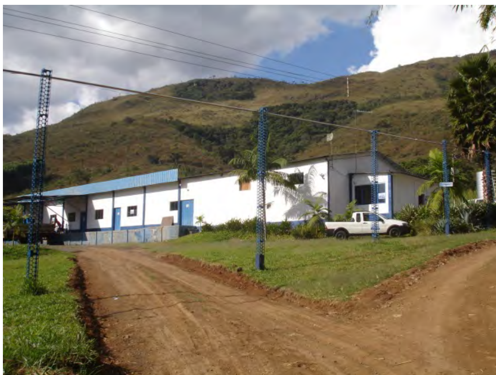
Foto 23 – Edificação das instalações industriais de produção de água mineral da Mineradora Serra da Prata em Águas da Prata.
