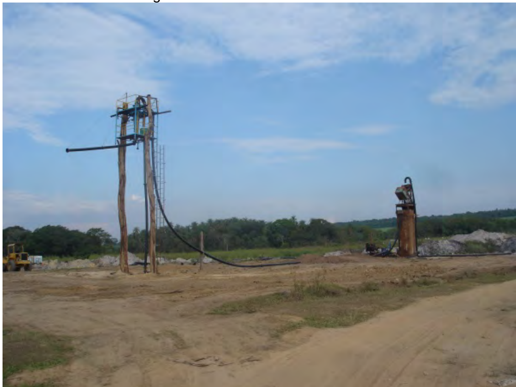
Foto 47 – Área operacional em fase de instalação (hidrociclone e peneiramento estático) de lavra de areia por dragagem em cava submersa após a retirada da argila por escavação mecânica a seco da Mineração Alonso em Aguai.
