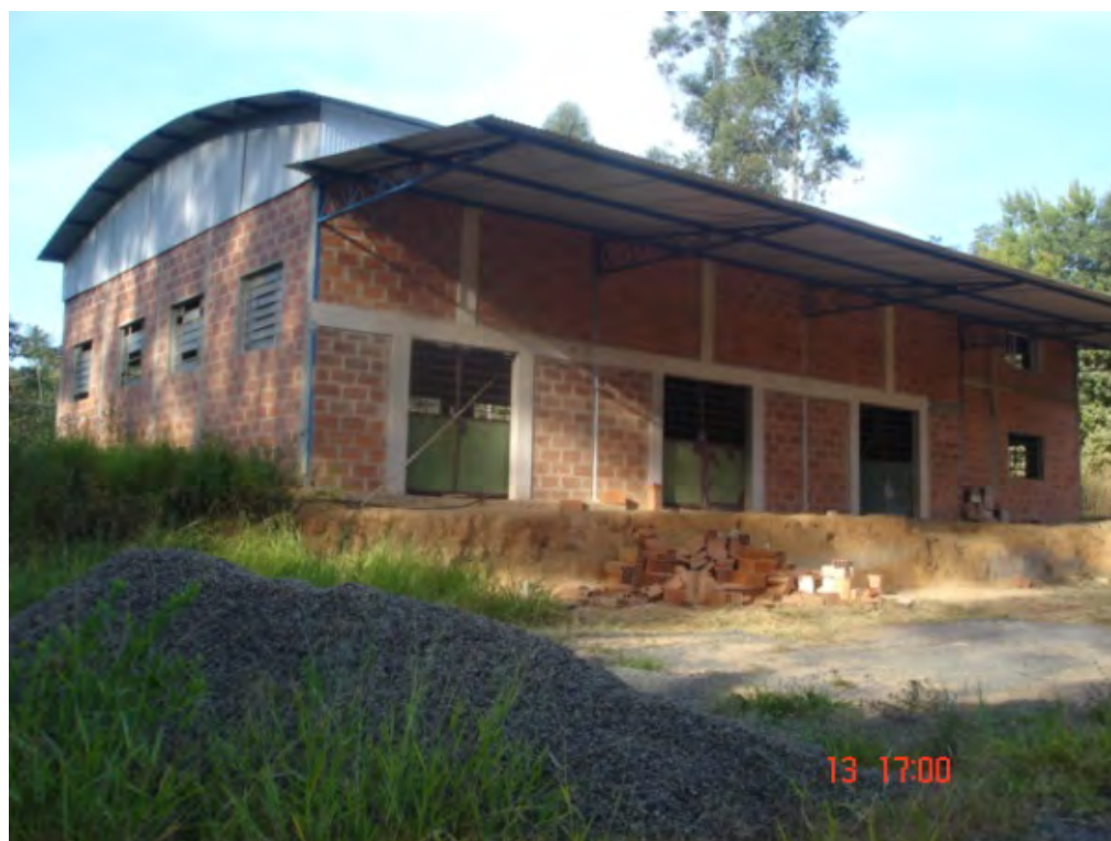
Foto 63 – Instalações em fase de construção para engarrafamento de água mineral da Mineral MB em Espírito Santo do Pinhal.
