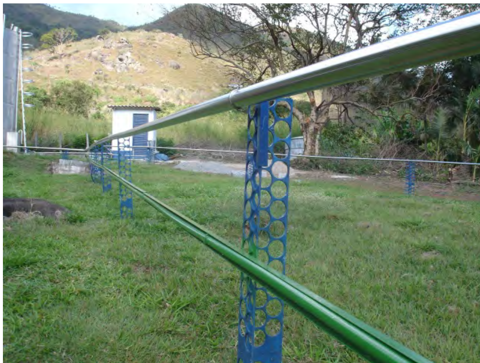
Foto 24 – Tubulações de transferência de água: linha prata para produção de água mineral e linha verde para operações auxiliares da Mineradora Serra da Prata em Águas da Prata.
