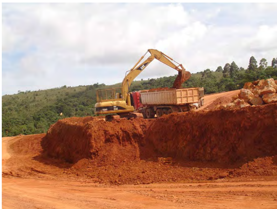
Foto 5 - Carregamento de caminhão com camada de capeamento da bauxita
