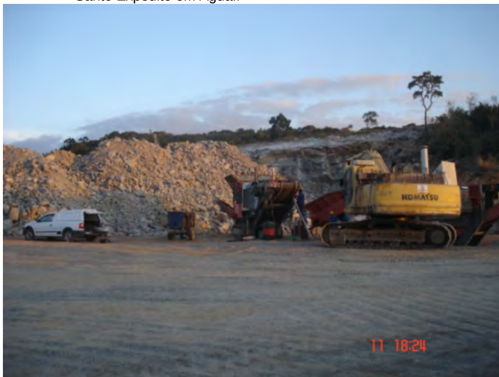
Foto 42 – Local de estocagem da produção de brita proveniente do decapeamento do maciço de charnoquito, produzida pela Sobrenco em Vargem Grande do Sul (local no limite com outros municípios).
