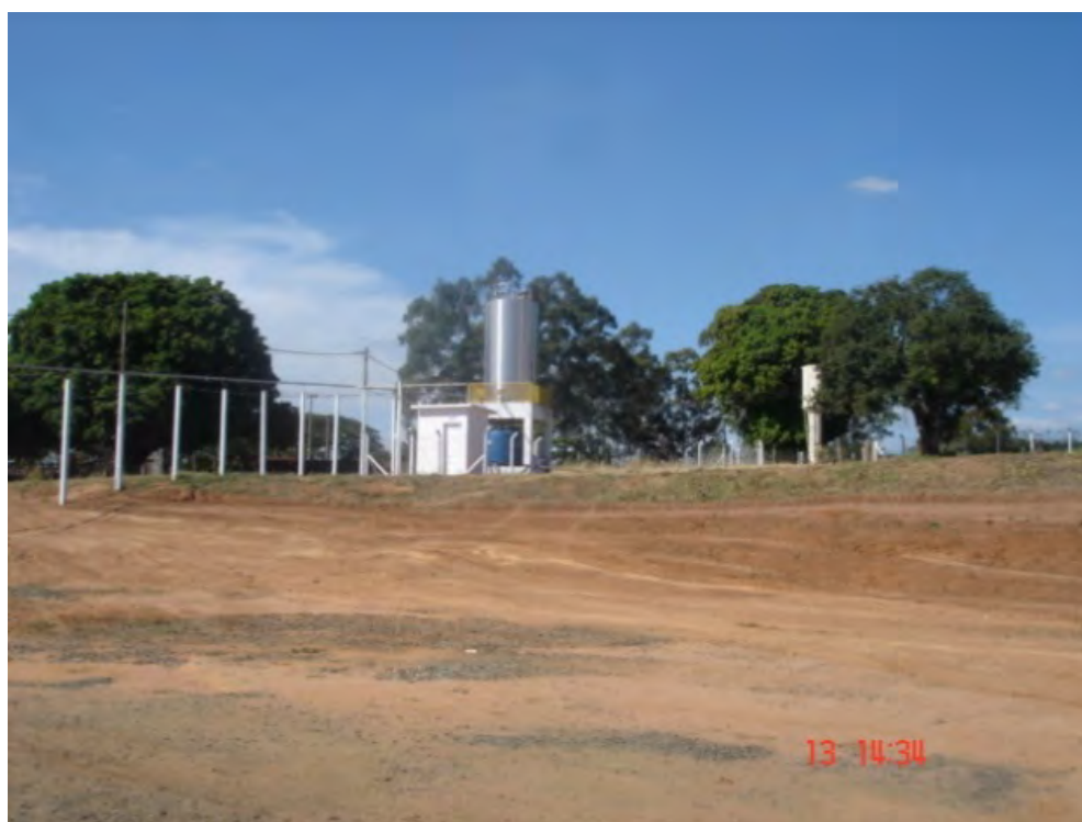
Foto 62 – Vista geral do local de captação da fonte da Mineração e Comércio de Água Mineral Sanchez (Água Mineral Guapurã) em Aguaí.
