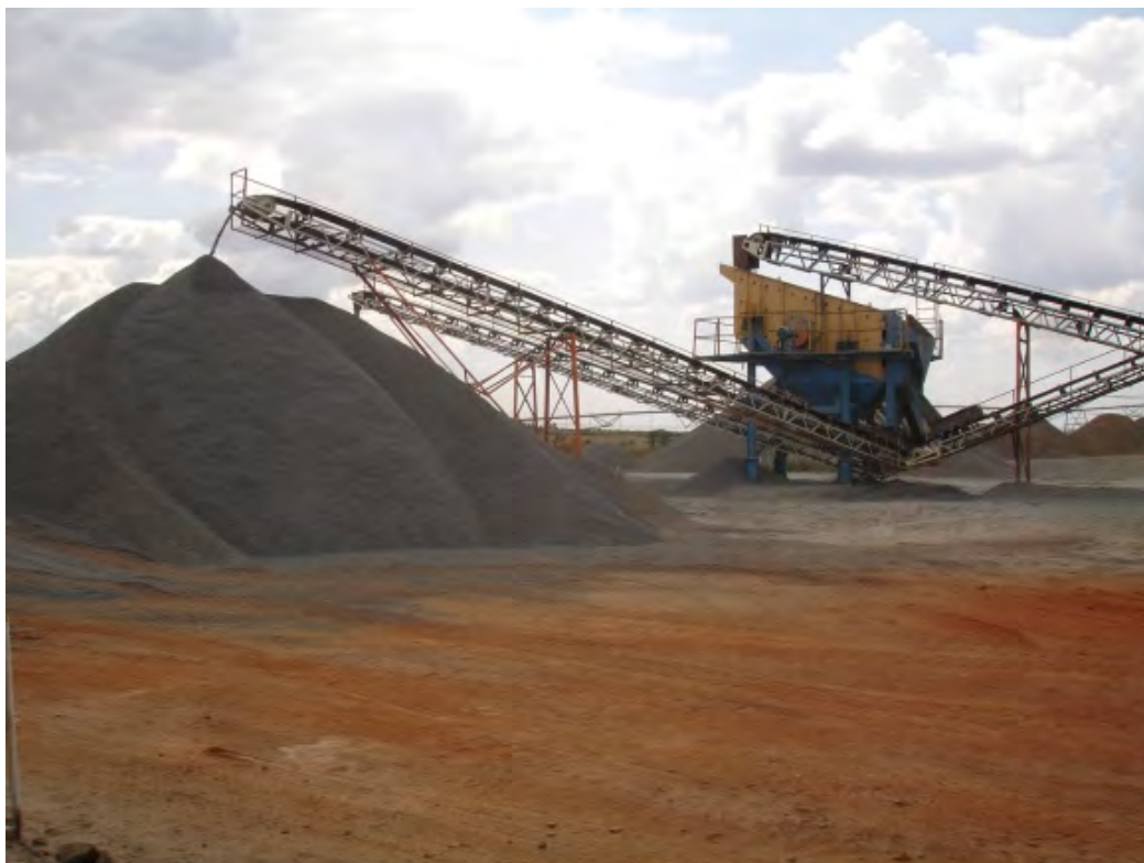
Foto 41 – Área operacional de beneficiamento da pedra da Pavimentadora Santo Expedito em Aguaí.
