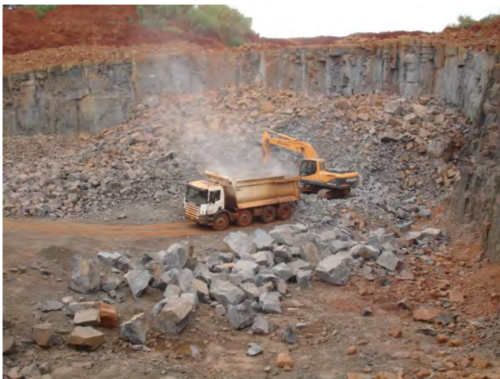
Foto 40 – Área operacional de lavra da pedreira da Pavimentadora Santo Expedito em Aguaí.
