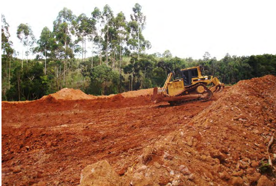
Foto 9 - Detalhe da operação de reconformação topográfica de área lavrada.
