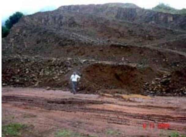
**Foto 9** – Frente de lavra em basalto semi alterado para utilização como cascalho, próximo ao Morro do Bofete. Pto 036CMB.
