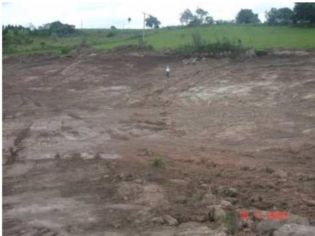
**Foto 5** – Cava em argilitos alterados da Formação Teresina. A base da cava está sobre argilitos pouco alterados (taguá). Pto 030OPC.
