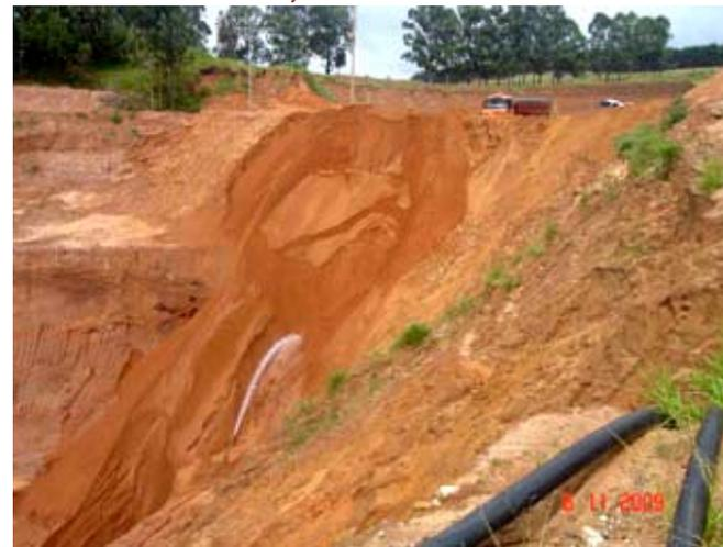
**Desmorte hidráulico em talude que suporta tráfego pesado de caminhões.**
