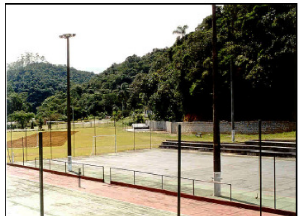
Foto 10 – Ao fundo vê-se caixa de captação para abastecimento do Hotel Pilar (fonte da montanha – secundária)
