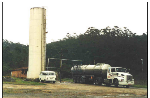
Foto 18 – Água Tibana: reservatório e caminhão tanque de água potável.
