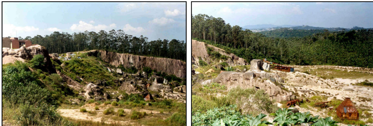
Fotos 36 e 37 – Panorama geral do porto de areia abandonado.
