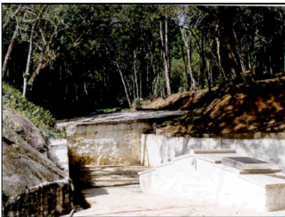
Foto 9 – Caixa de captação d’água da principal fonte dos pinheiros
