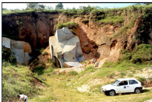
Foto 41 – Restos de matações onde foram extraídos paralelepípedos.
