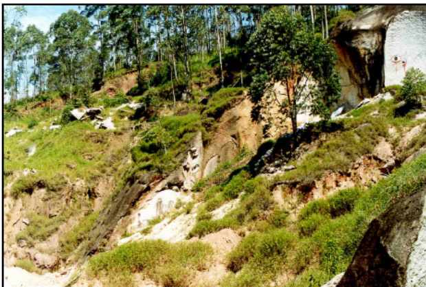
Foto 29 – Área Ananias, a mais expressiva frente de lavra dos canteiros.
