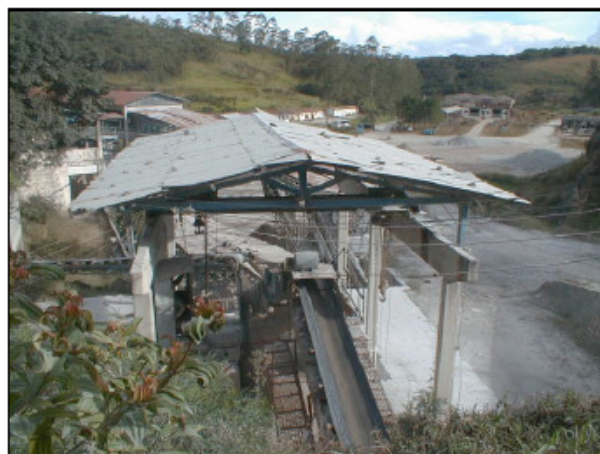
Foto 6 – Unidade de britagem secundária da Pedreira Anhanguera.
