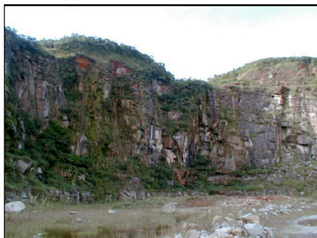
Foto 4 – Frente de lavra paralisada em paredão com altura superior a 40 metros
