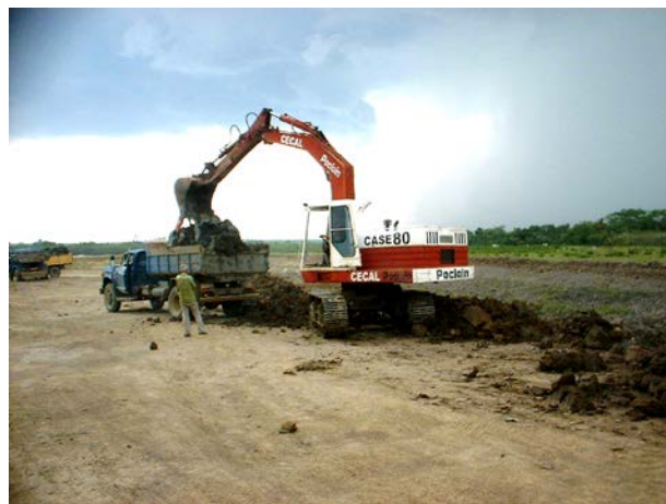
Foto 12 - Operação de carregamento da argila em caminhão para transporte até as pilhas de estocagem ( Barreiro da Cerâmica Rincão).
