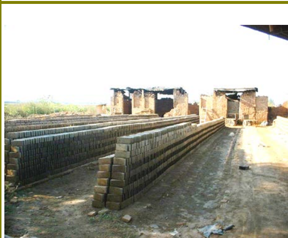
63 – Secagem a céu aberto e fornos tipo caipira ao fundo.
