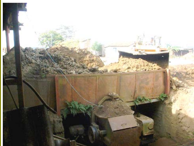
52 – Alimentação de argila por retro escavadeira.
