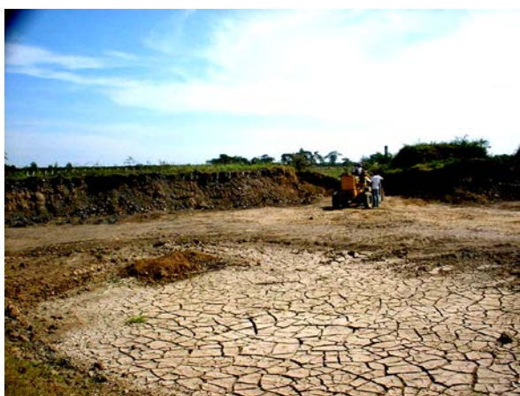
47 – Estoque de argila no local.
