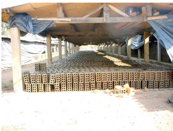
55 – Galpão para secagem dos tijolos.
