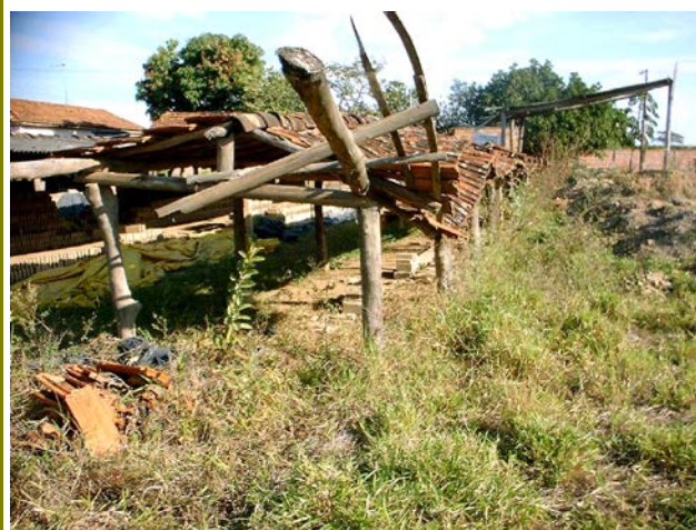
62 –Pátio de secagem abandonado.
