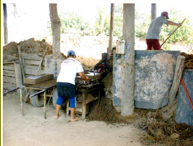
78 – Alimentação manual e extrusora para fabricação de tijolo liso.
