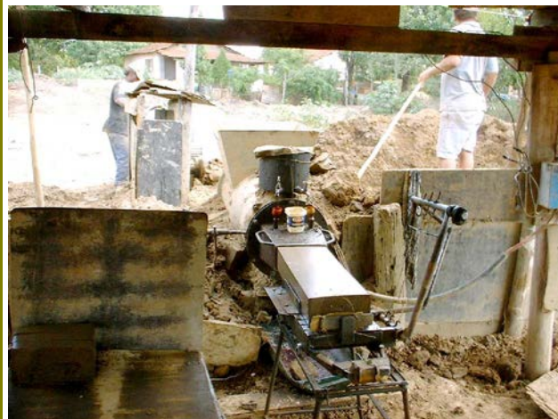
81 – Alimentação manual e extrusora para fabricação de tijolo liso.
