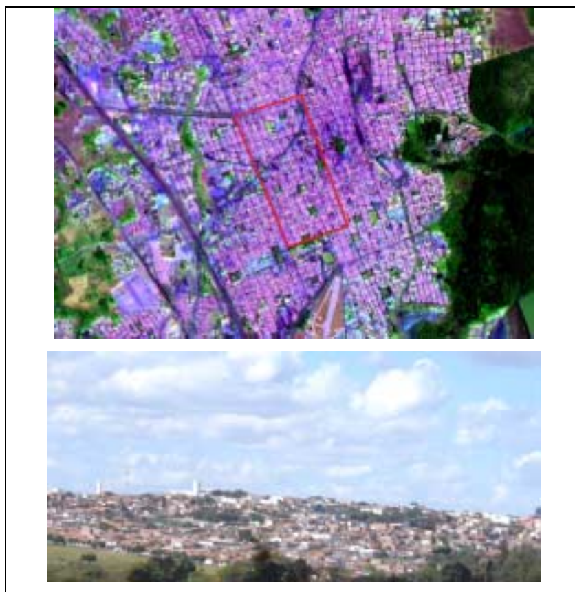
Figura 58 - Composição de imagem de satélite e fotografia em campo de área de ocupação urbana.
